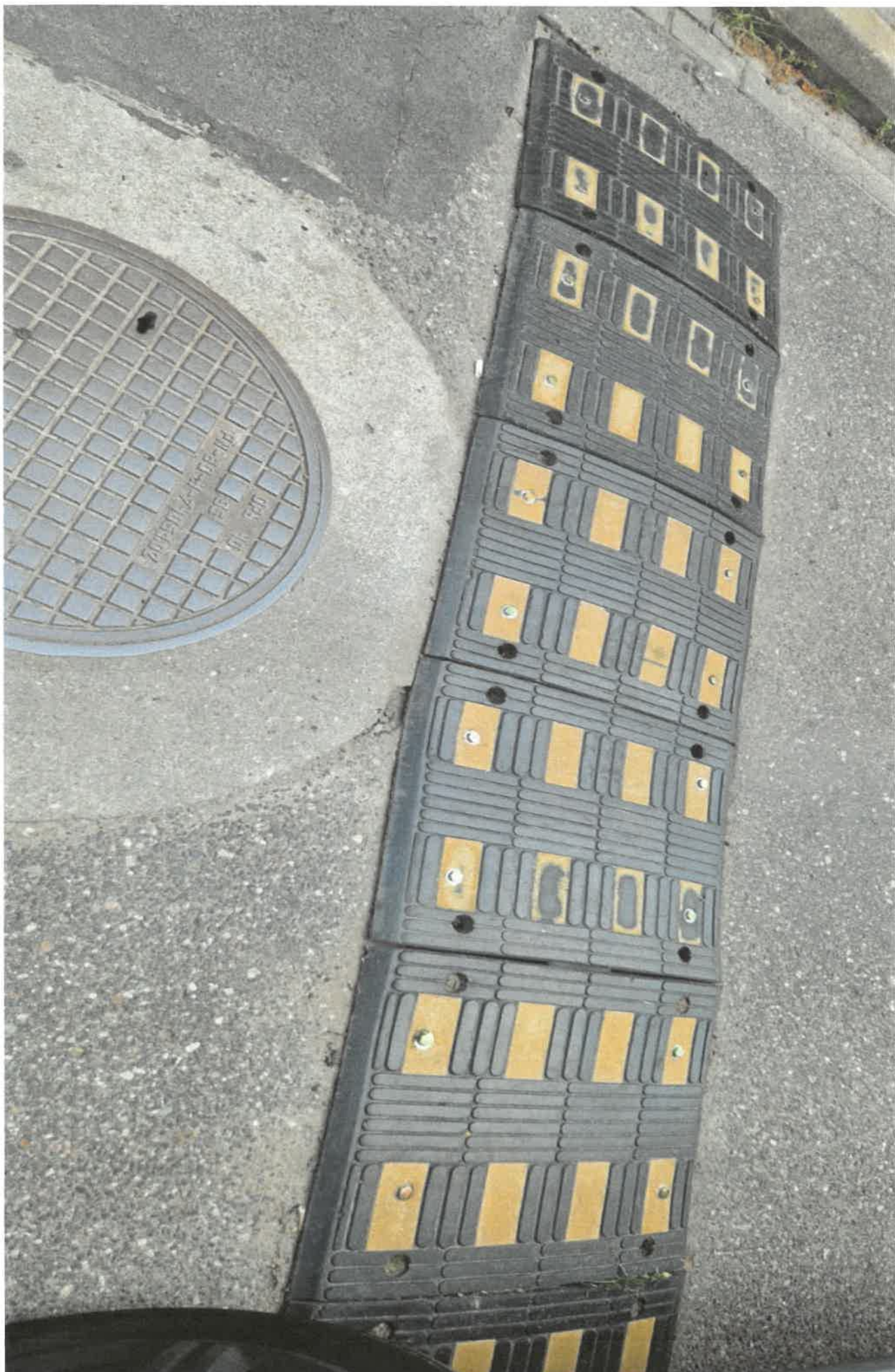
Załącznik do interpelacji: fotografia montażu elementów progu zwalniającego na ulicy Lipowej w Rawiczu.
